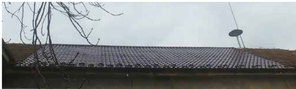
Nová střecha na Sokolovně
