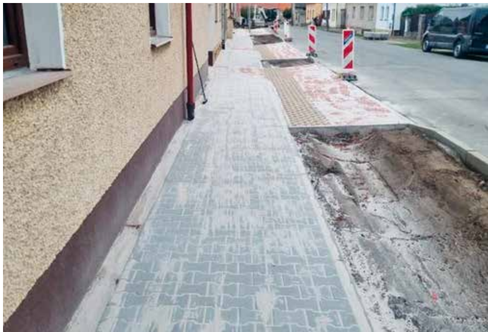
Nově vybudovaný chodník, kde bude mít každá nemovitost zřízené parkovací stání
