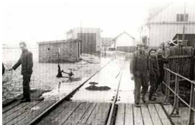
Povodeň 13. 3. 1940 (železniční most)
