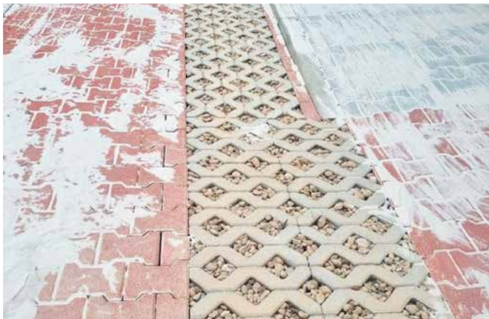
Nově vybudované vsakovací pásy
